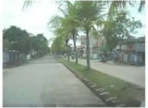
Jalan utama perumahan
